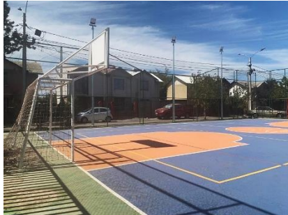
Demarcación Losa de Juegos.
