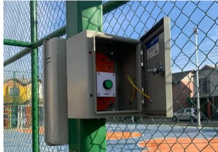
Normalización de Tablero eléctrico.
